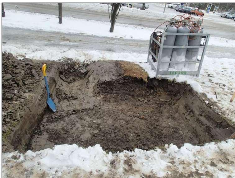
Valmis kaivanto. Lapio nojaa kaivannon pohjoisprofiiliin. Itään.
