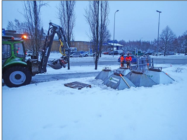
Valvonnassa kaivettu alue ns. routamattojen alla, ennen kaivamisen aloittamista. Kaakkoon.
